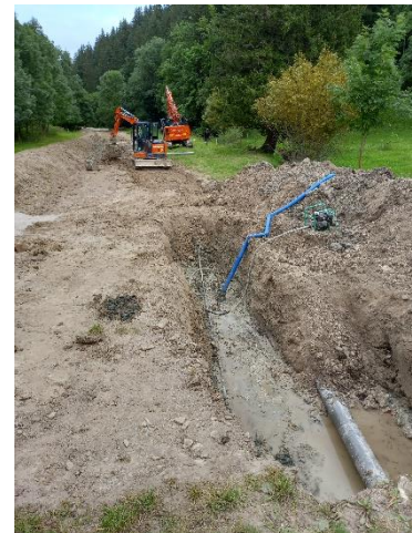
Travaux de reprise du réseau d'assainissement et des berges du Corrençonais La Font de la Maie
