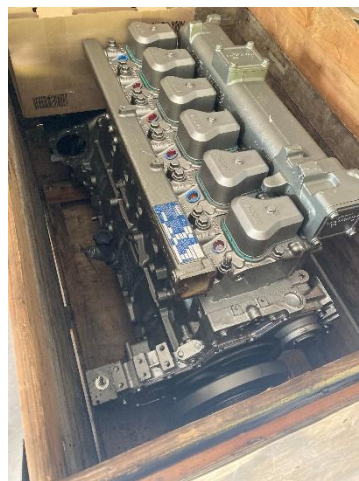
Renouvellement moteur cogénération STEU de Fenat
