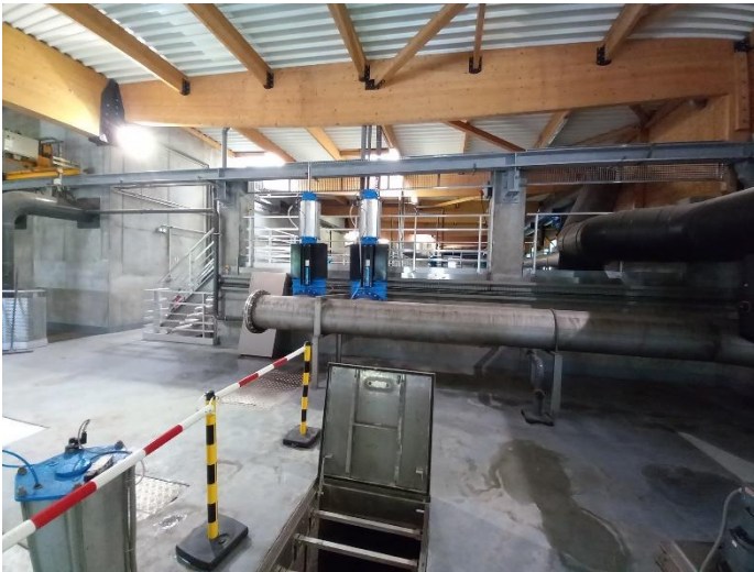
Station d'épuration de Fenat
